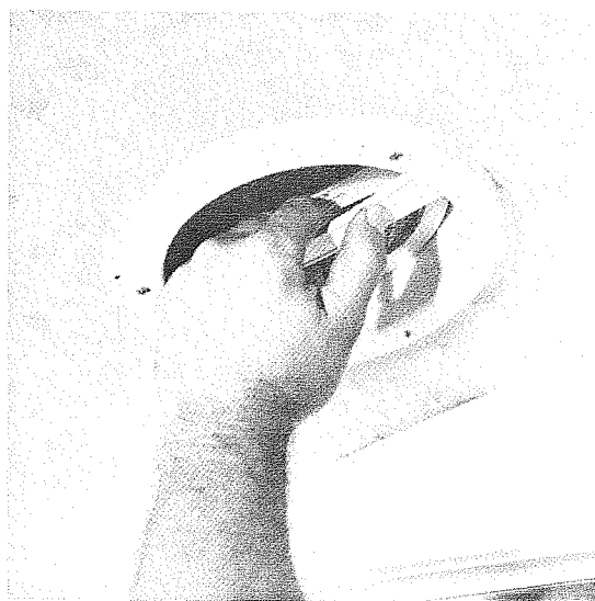
Bathroom Exhaust Fan
